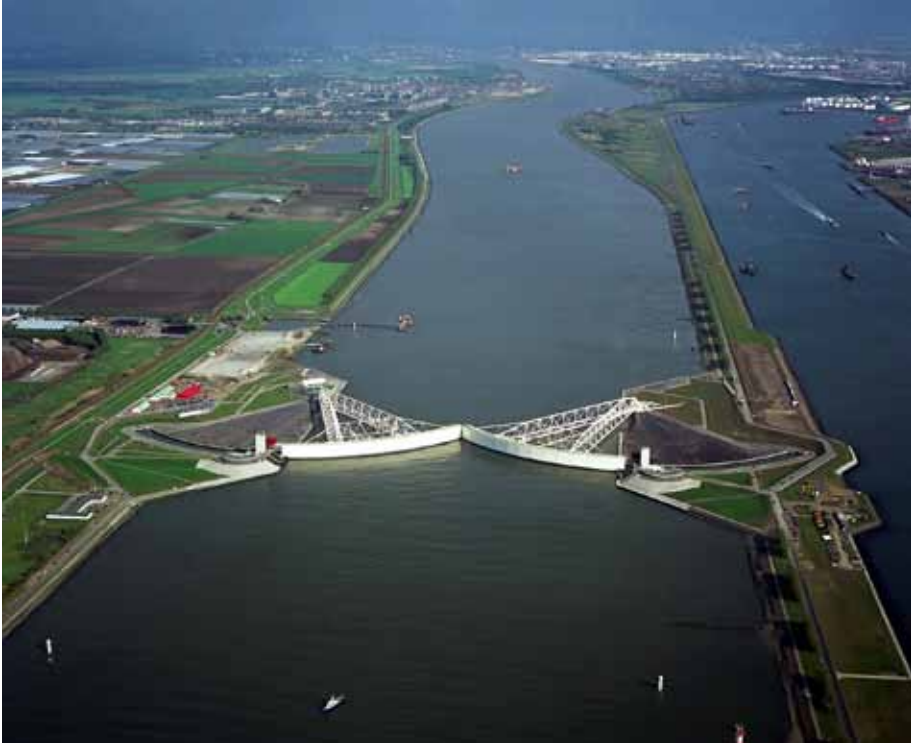
Figure 2.2: The Maeslantkering in the Nieuwe Waterweg (Photo: Rijkswaterstaat)
