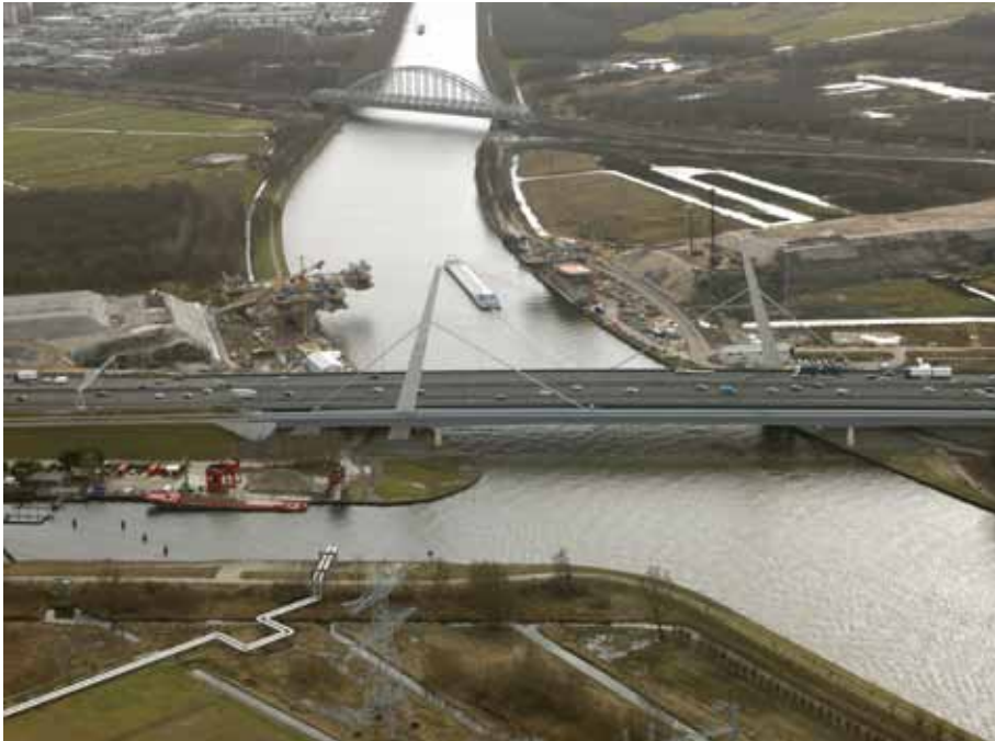
Figure 6.6: The Muiderbrug on the A1 motorway over the Amsterdam-Rijnkanaal (Photo: Rijkswaterstaat)
